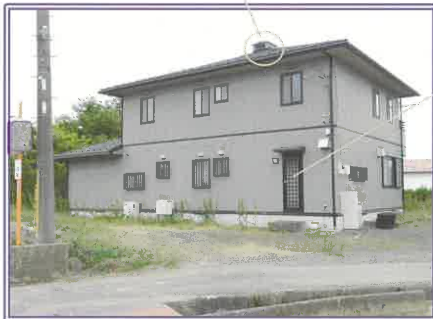
裏側近景（建物手前の空地は 物件1の宅地）
