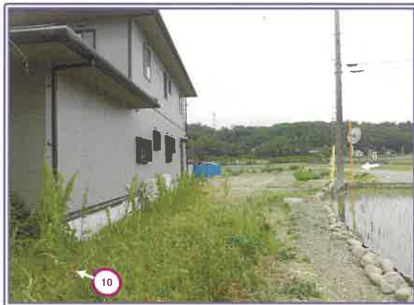
建物脇の裏側空地（＝物件1の宅地）と右端の隣地（2-1・耕作田）
