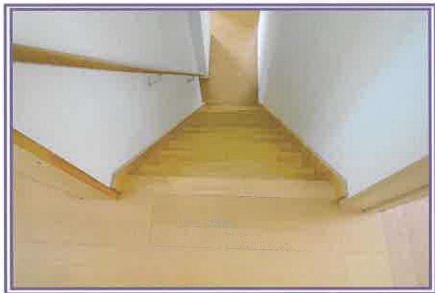
屋根裏部分から、2階へ向かう階段方向を撮影したもの
