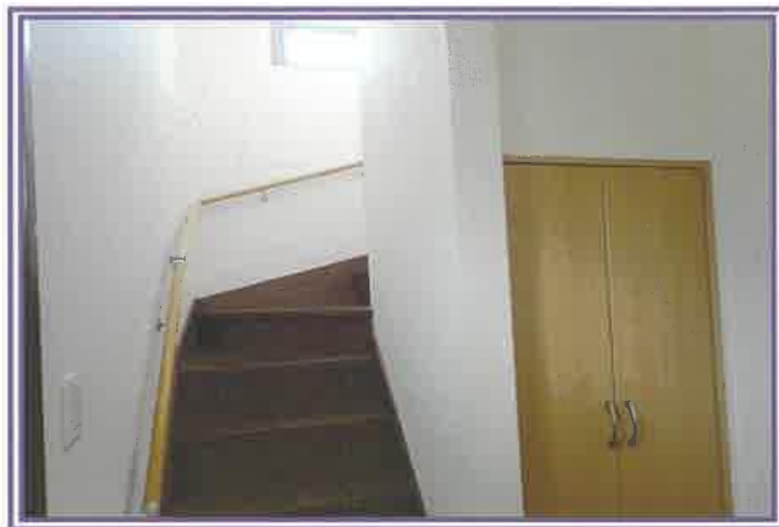
玄関1から、階段方向を撮影したもの
