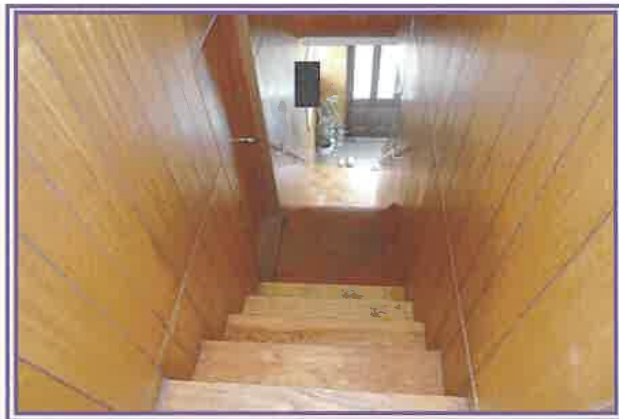
2階から、階段方向を撮影したもの
