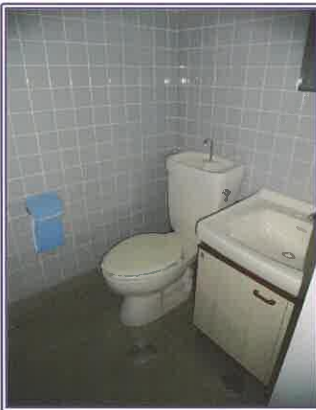
トイレ（306号室・物件1の区分所有建物）
