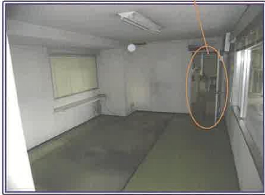
事務室（307号室・物件1の区分所有建物）
