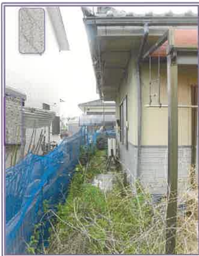
横（西）側 敷地内の状況
