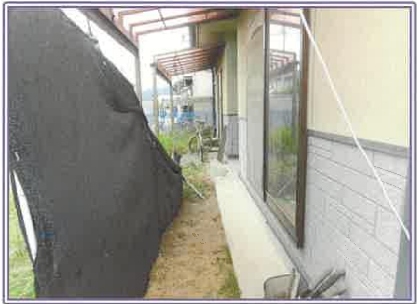
雨除下の状況
