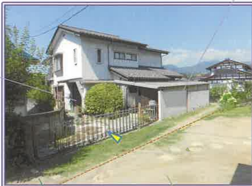
出入口側全景
