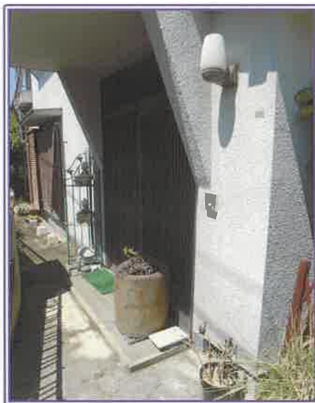
玄関前の状況
