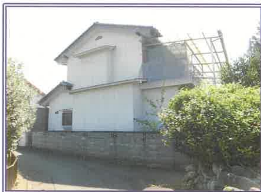
横（舗装道路）側近景
