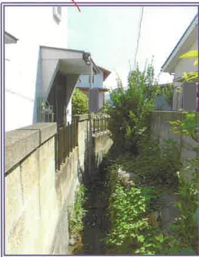
隣接水路の状況
