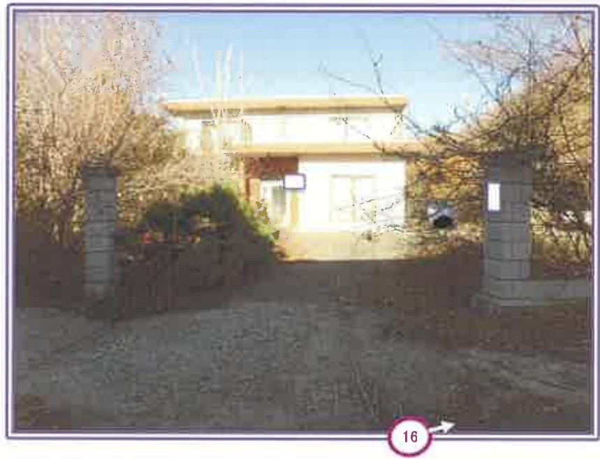
門構の状況（奥は居宅（物件8・主たる建物））
