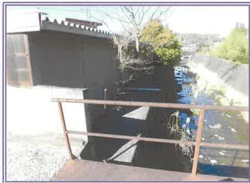
水路（六反川）との 接面状況
