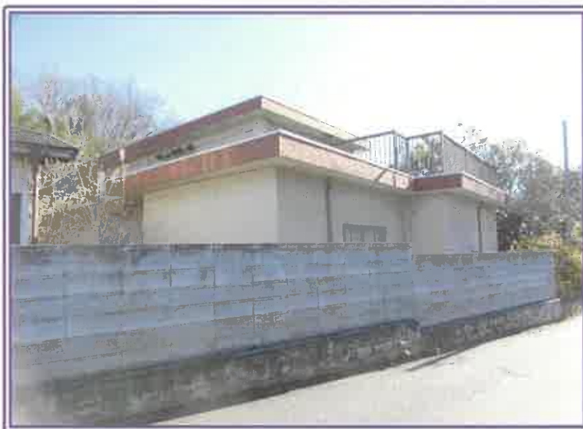
居宅（物件8・主たる建物）の道路側近景
