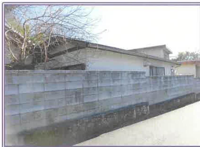
居宅（物件9・建物）の道路側近景
