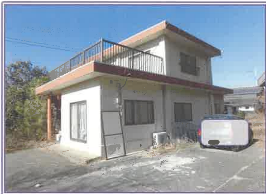
居宅（物件8・主たる建物）の横側近景
