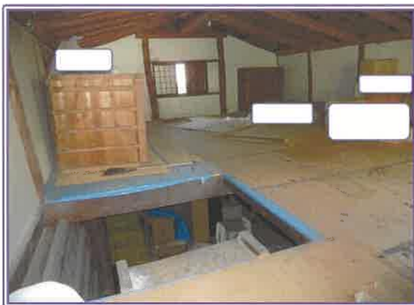
2階 物置（物件8・附属建物2）
