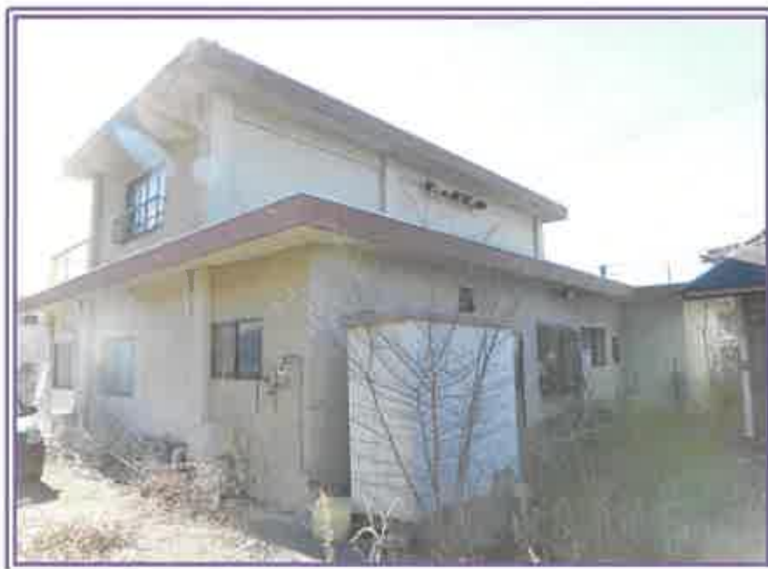
居宅（物件8・主たる建物）の裏側近景
