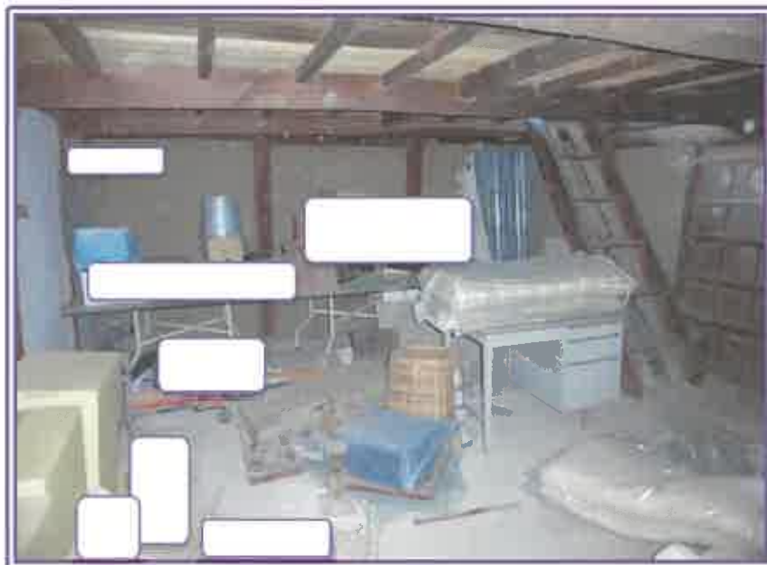
1階 物置（物件8・附属建物2）
