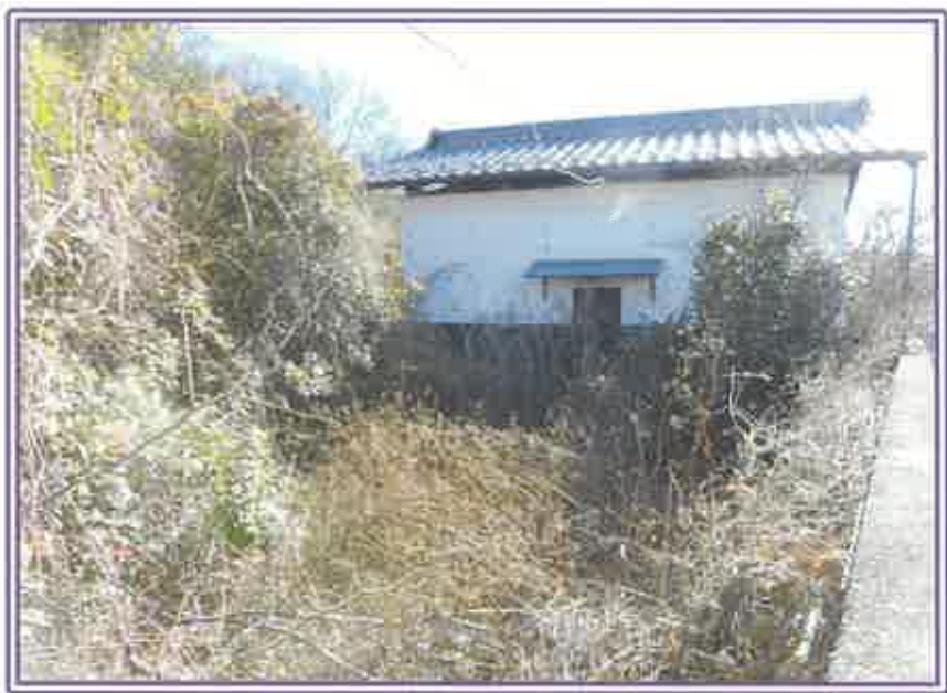
敷地内の状況（奥は 物置（物件8・附属建物2））
