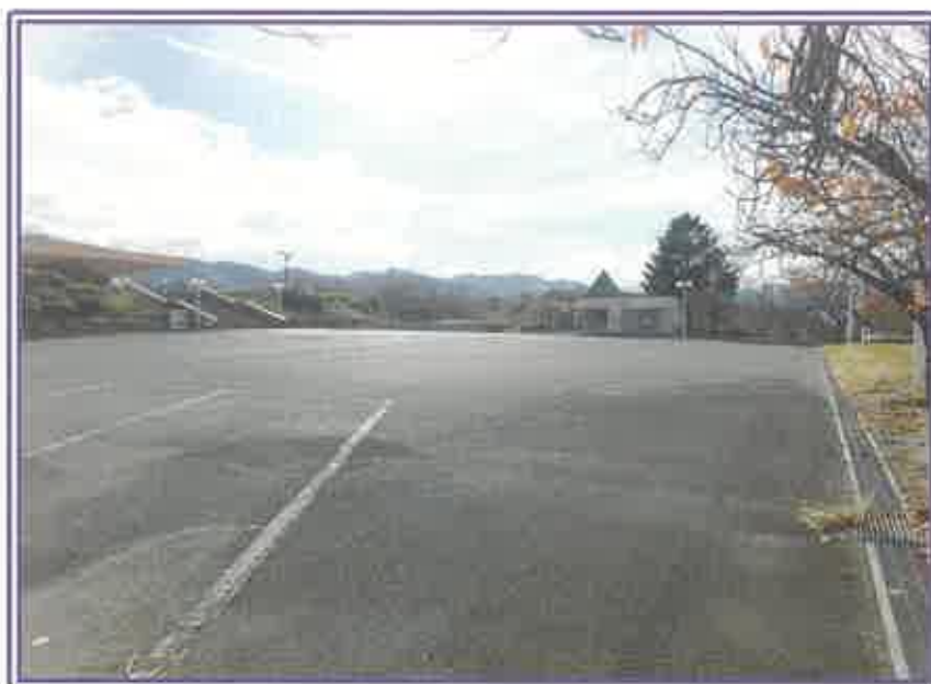
北側（観光客用）駐車場（奥は 未登記附属建物 3）
