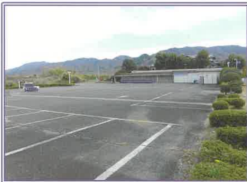
南側（従業員用）駐車場（右奥は 未登記附属建物1・2）
