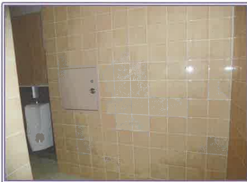
1階 エントランスホール脇のトイレ
