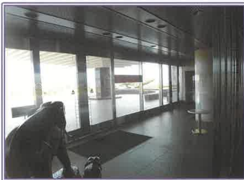
1階 エントランスホール前の 風除室
