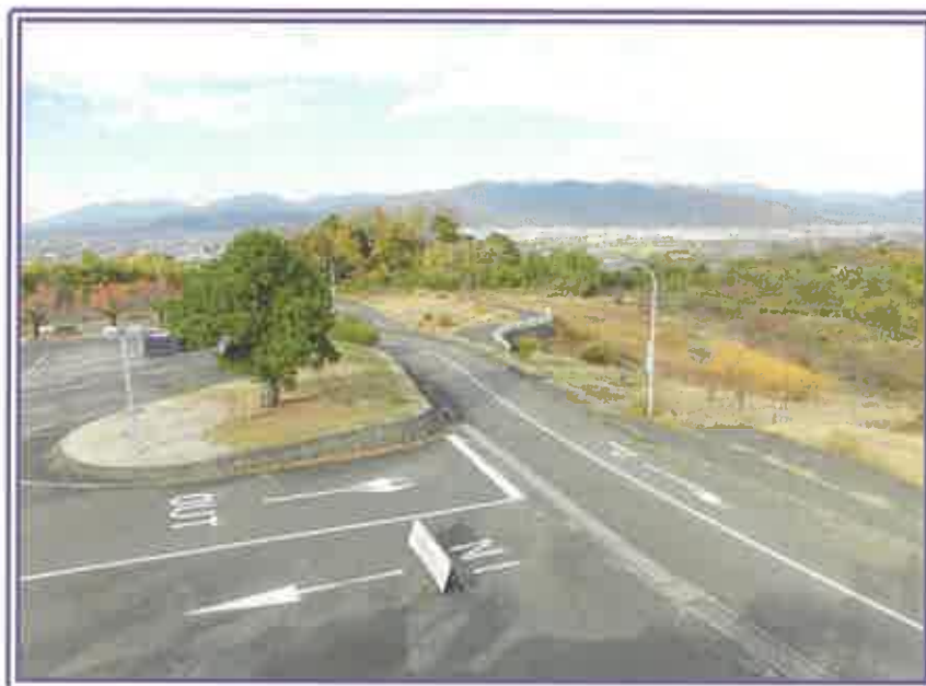
北側駐車場の接道状況
