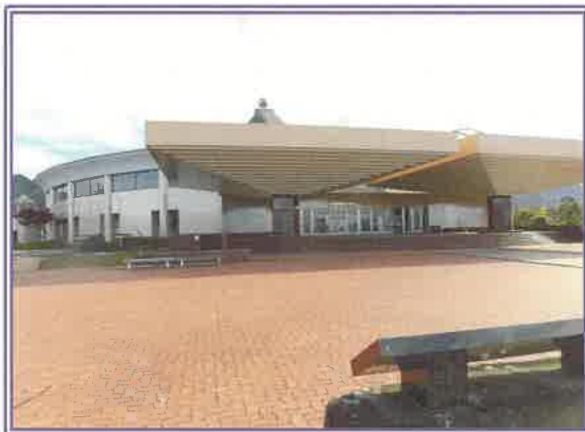
主たる建物の正面遠景
