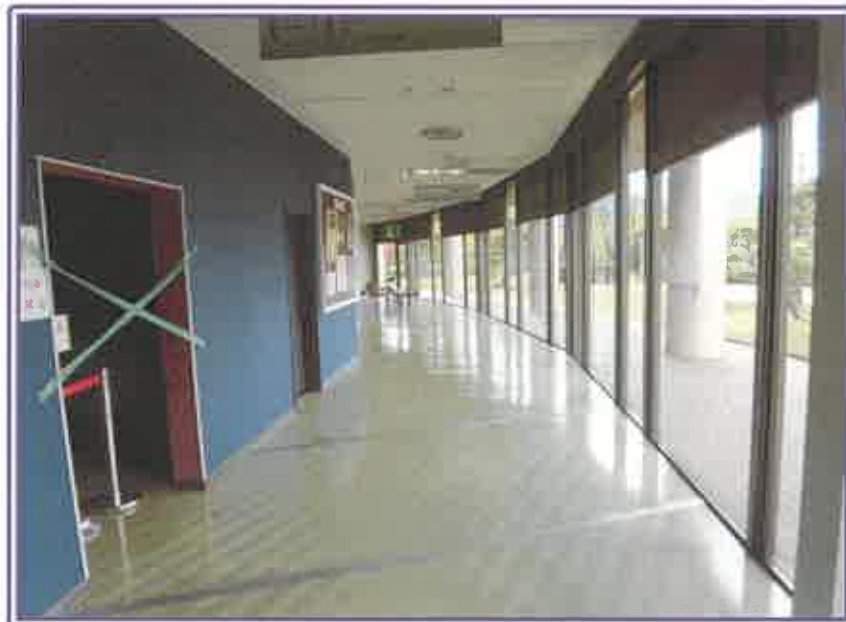
1階 窓際通路（奥が写真49の箇所）
