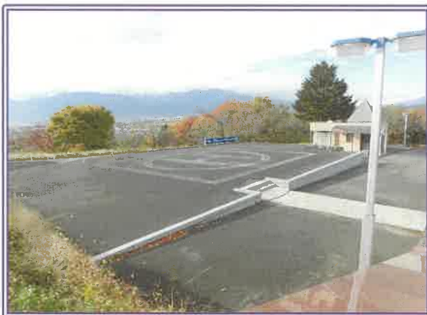
管理室・トイレ 脇のヘリポート
