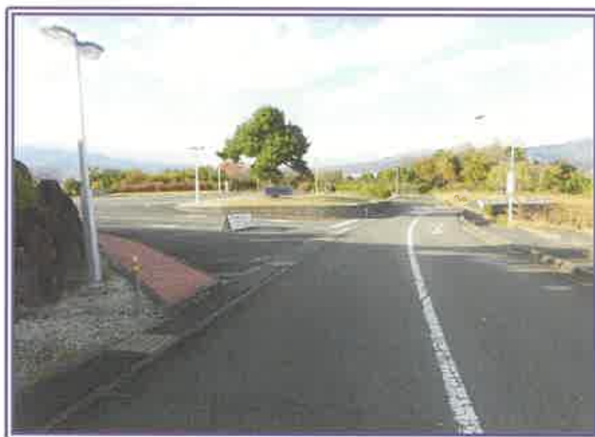
北側駐車場の接道状況
