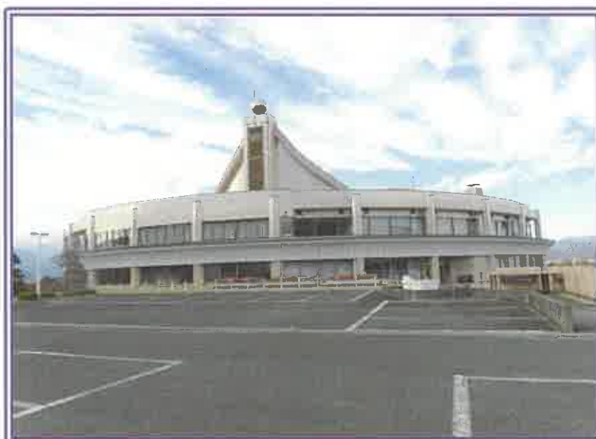
主たる建物の 裏側全景
