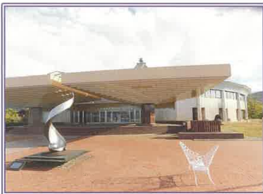
主たる建物の正面遠景
