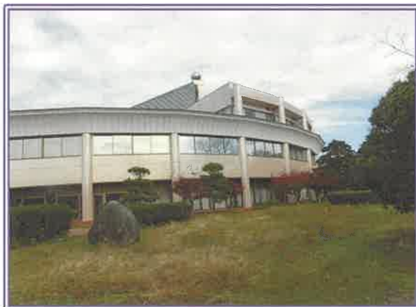
主たる建物の側面近景と 庭園（西側）
