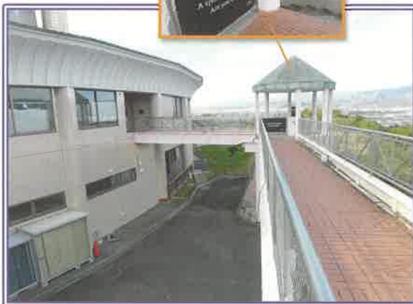
主たる建物の側面近景と 通路
