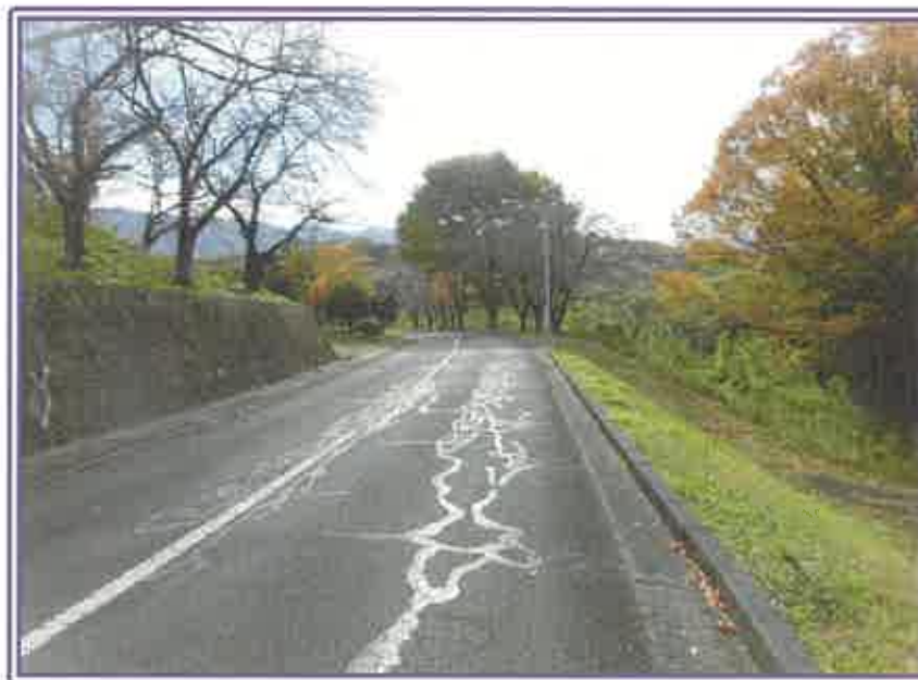
道路状況（奥は写真32の箇所）
