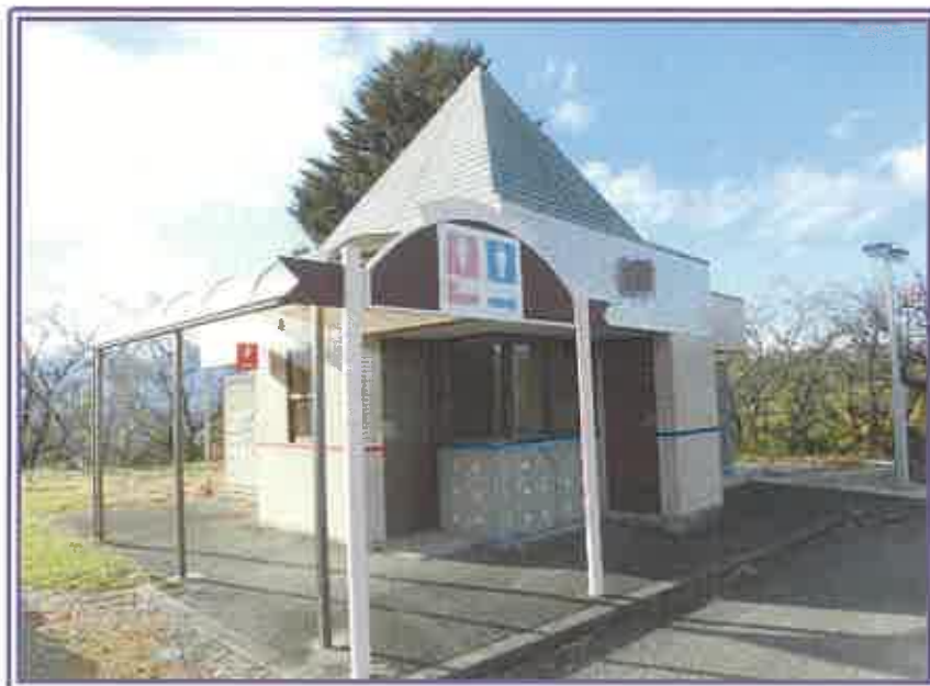
未登記附属建物 3 (管理室・トイレ)
