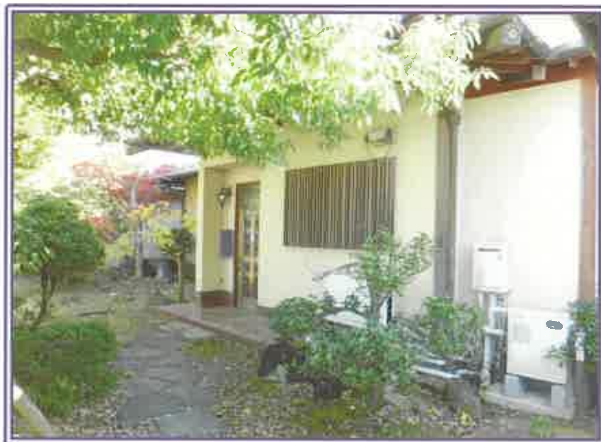
本件建物の裏側近景
