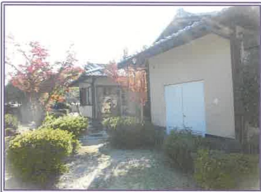
本件建物の裏側近景
