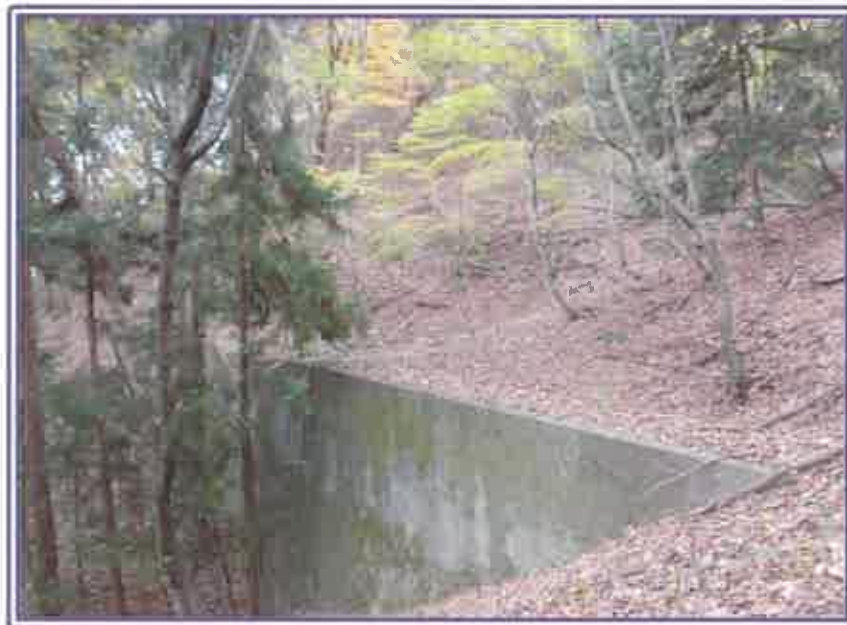
手前の堰堤の近景
