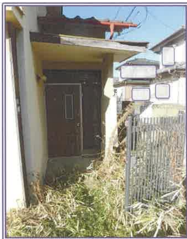
玄関前の状況
