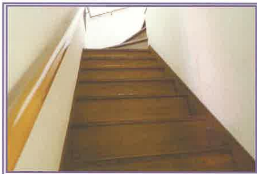
1階から、階段方向を撮影したもの
