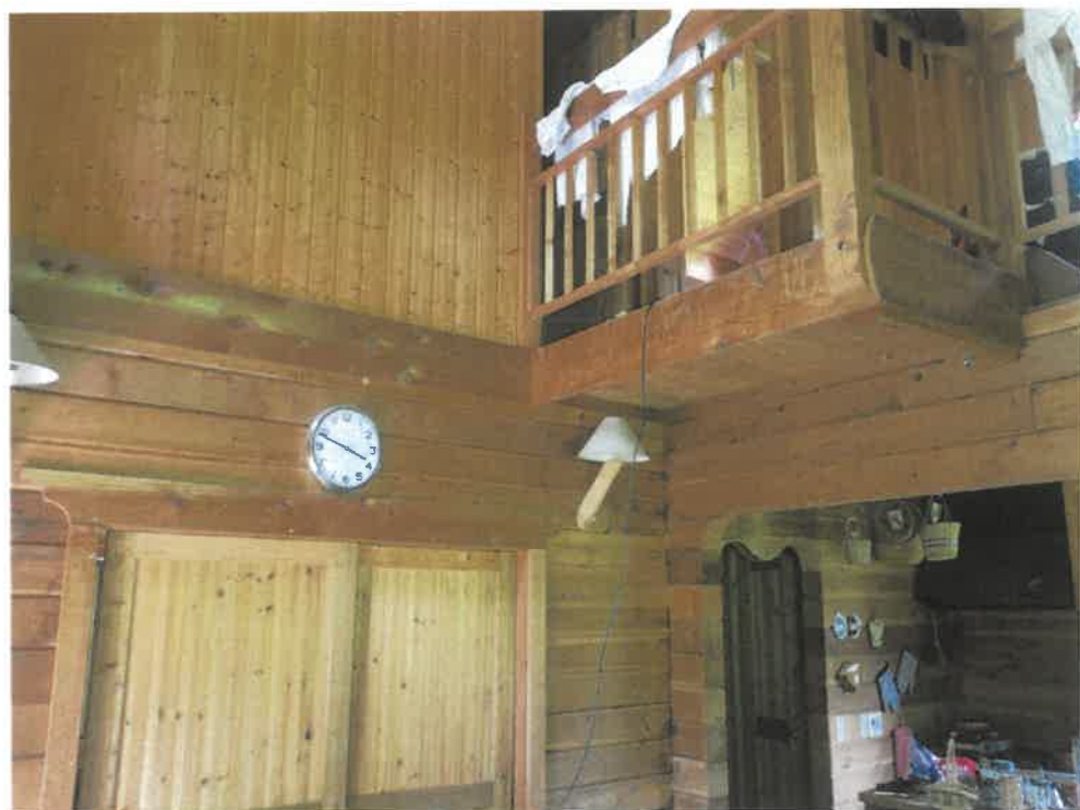
② 対象建物内部
