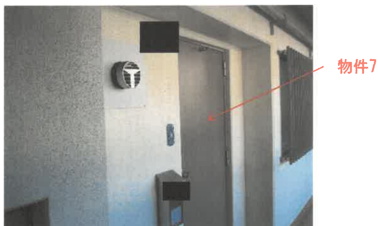
北東方より撮影
