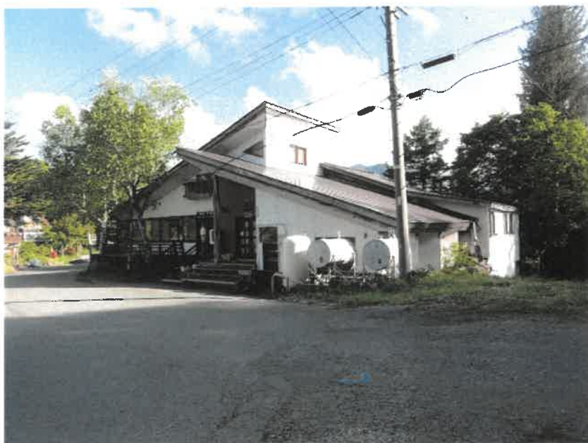
物件 7 北東方から撮影
