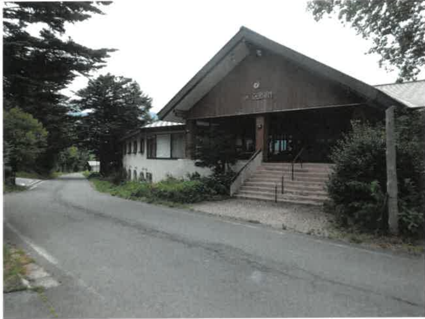
物件 6 北東方から撮影
