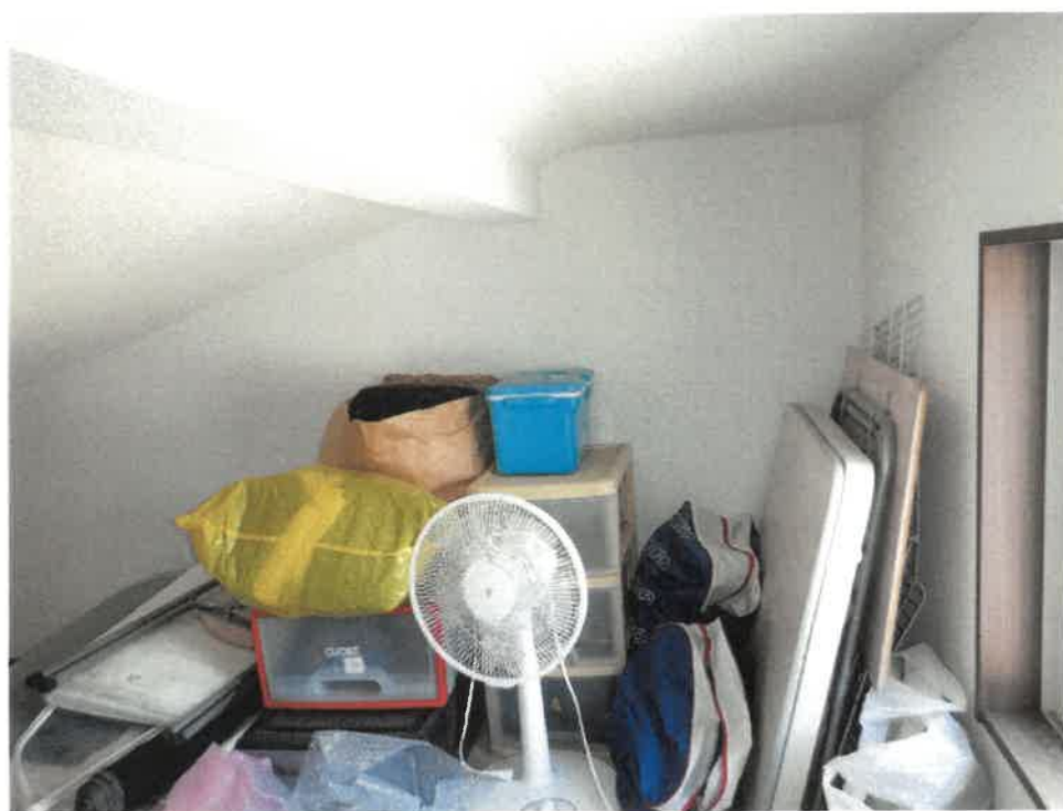
小屋裏収納部分
