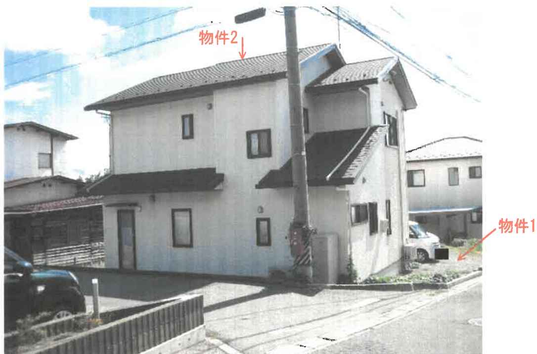
北西方より撮影
