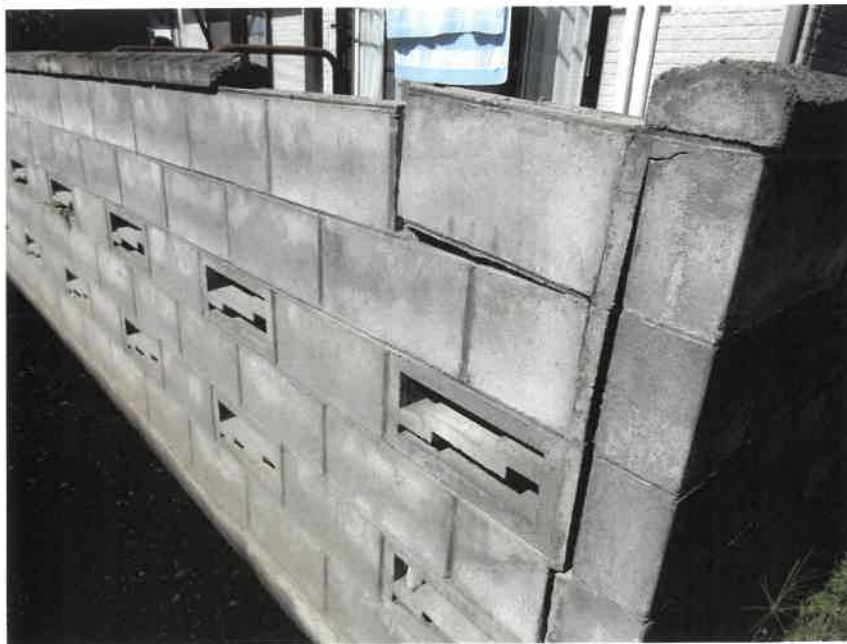
ブロック塀（通路側）
