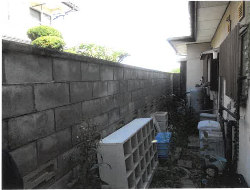
ブロック塀（北側）
