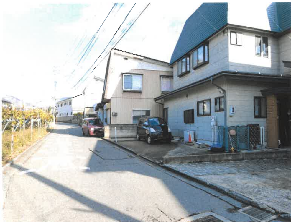
① 南西方向から接面道路及び対象物件
