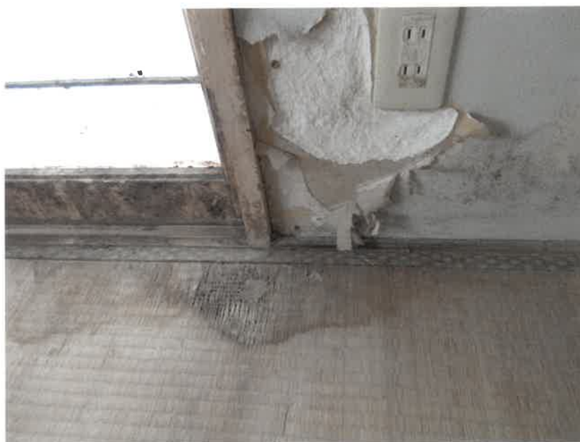
1階和室の床と壁の間付近
