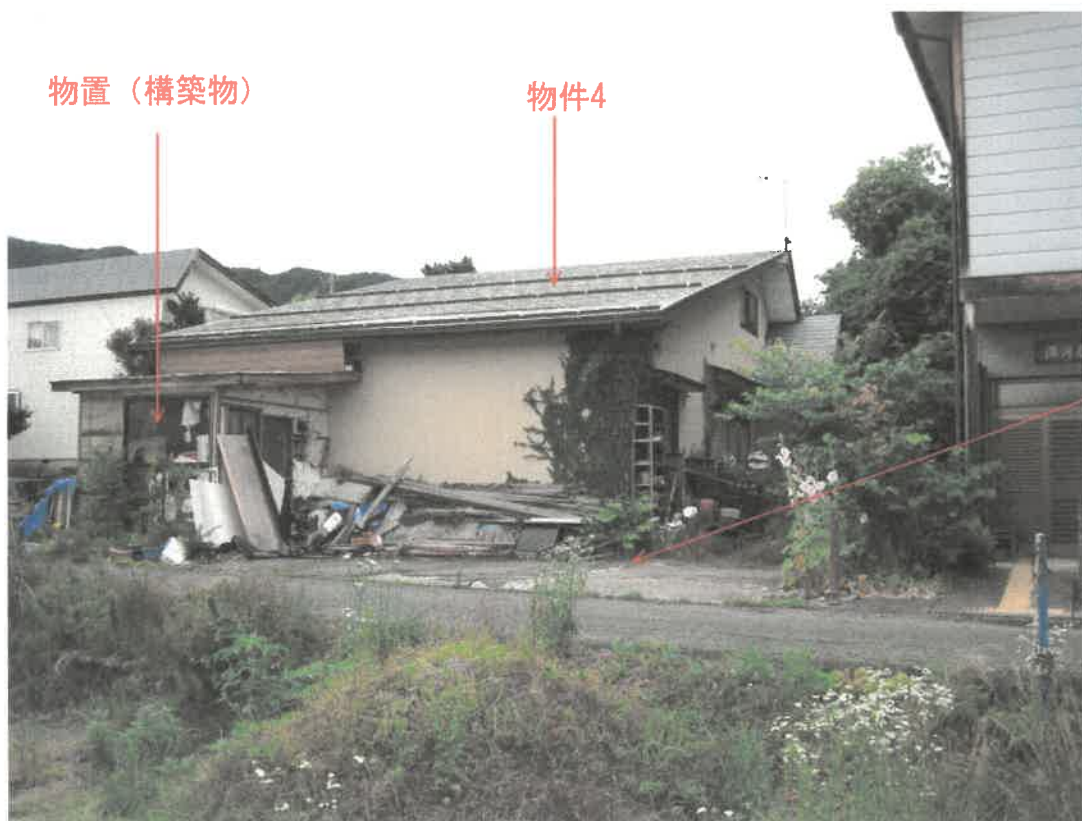
西方より撮影
