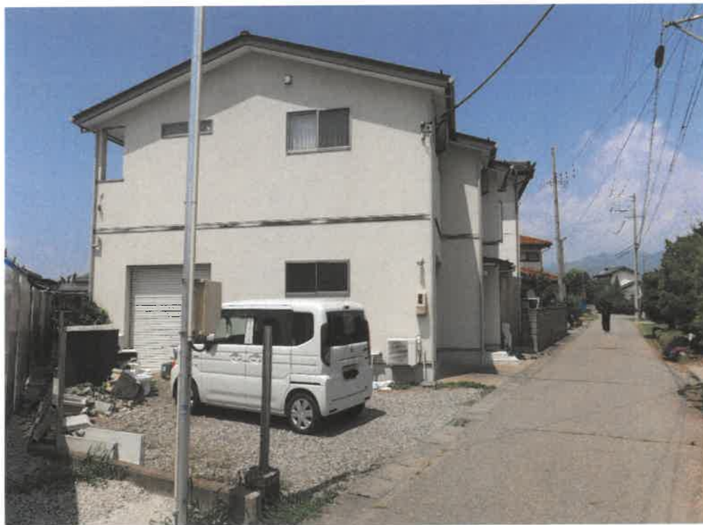
① 南東方向から接面道路及び対象物件全景
