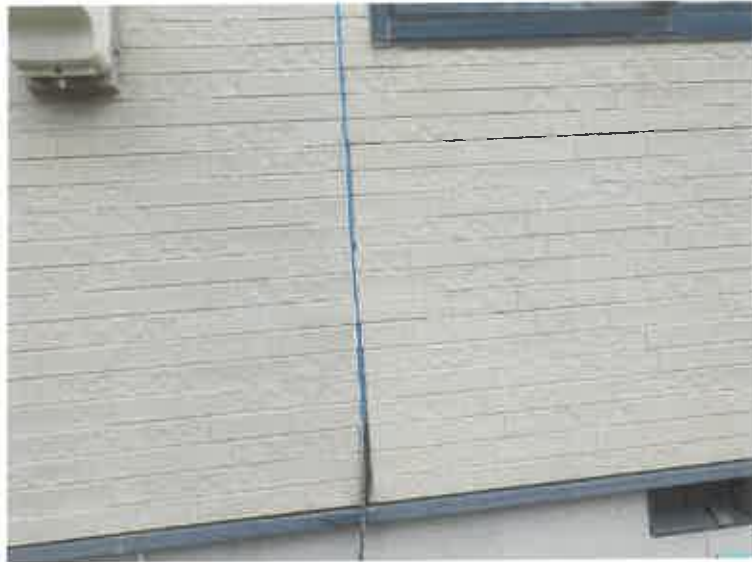
NO 13 外壁材の継ぎ目の状況
