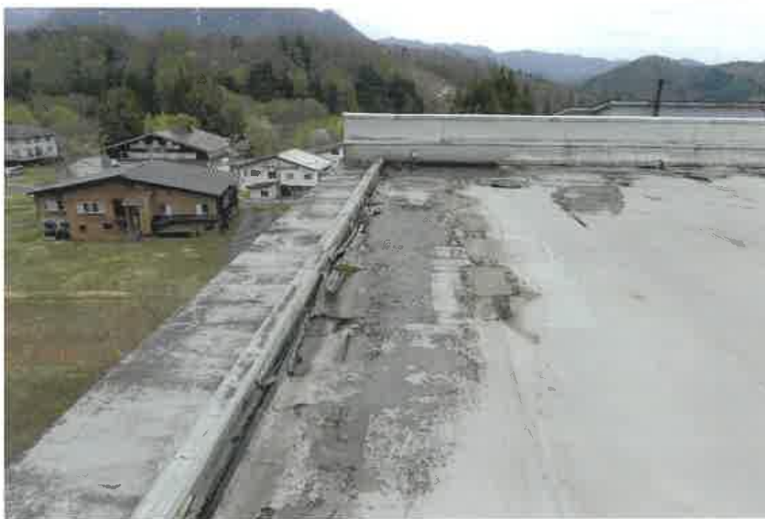
写真⑨（屋上）
