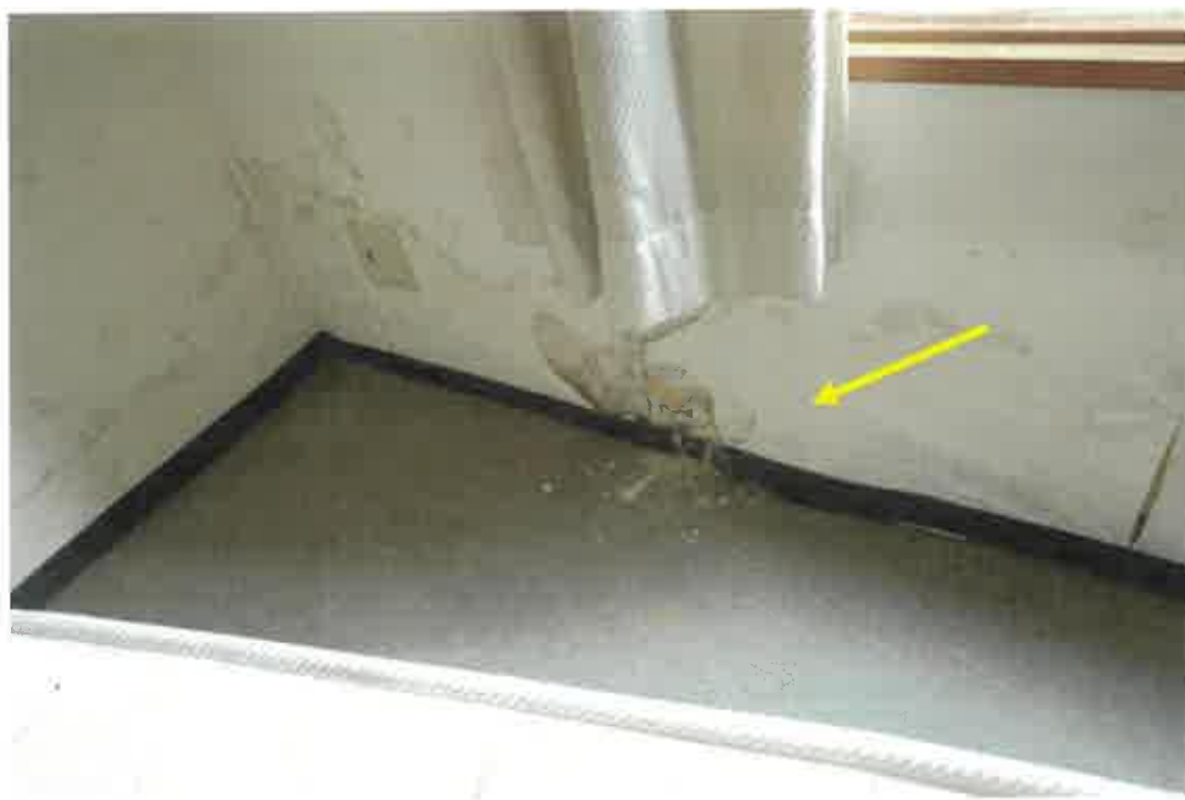
写真②④ (地下1階従業員室)
