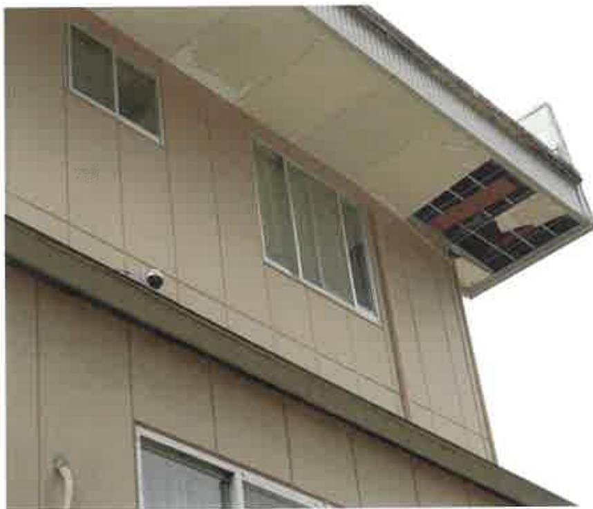
写真⑫（屋上庇）
