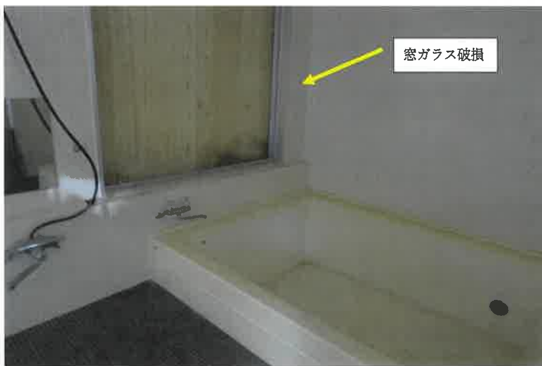
写真②③ (地下1階浴室)
