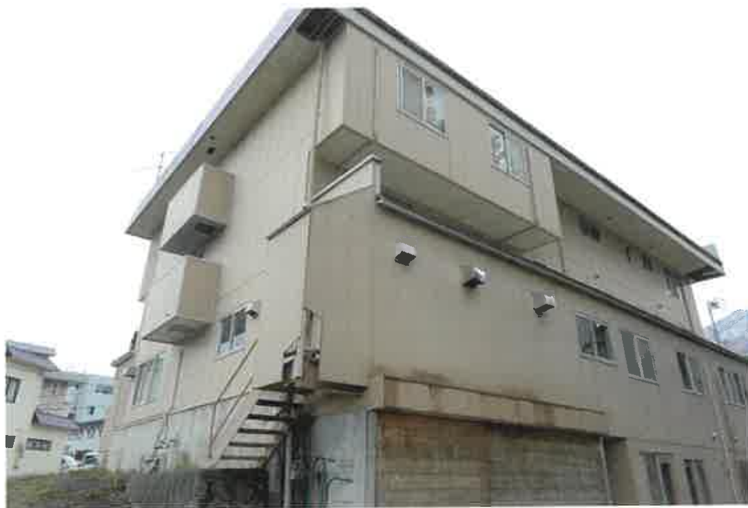
写真⑧（南東方向から撮影）
