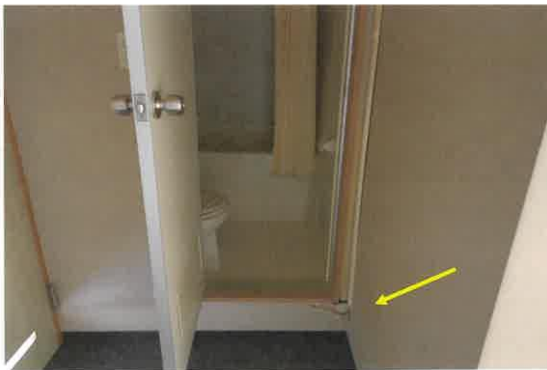
写真⑱（客室トイレ）
