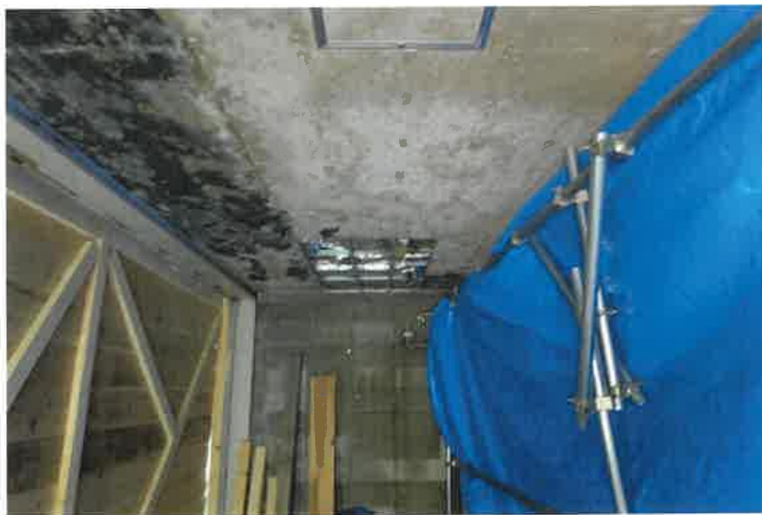
写真㉑ (地下1階倉庫)
