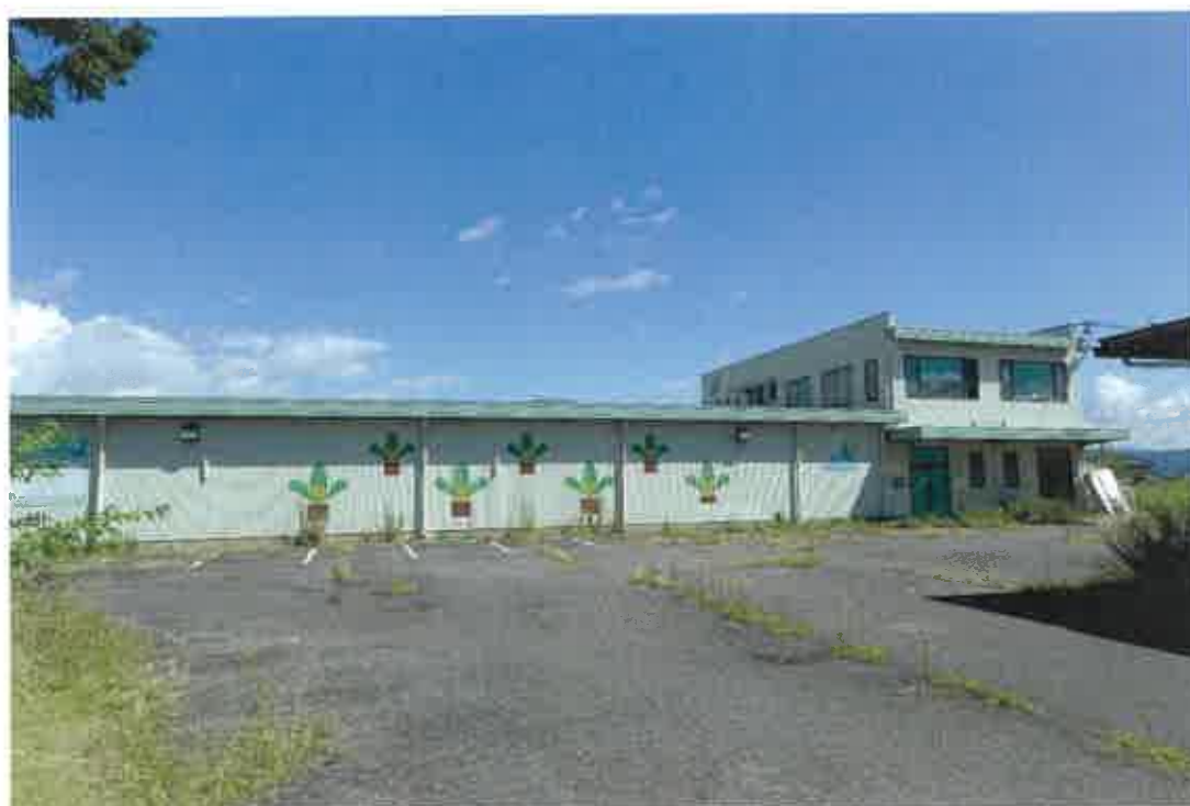
写真④（南西方向から撮影）
