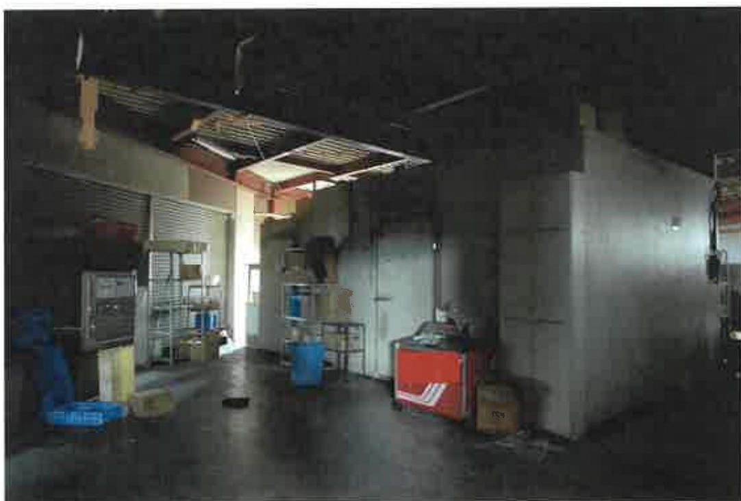
写真㉔ (1階倉庫)
