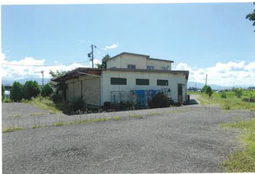
写真⑥（北西方向から撮影）
