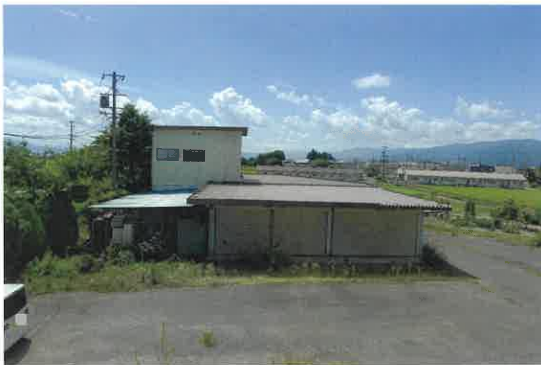
写真⑦（北方向から撮影）
