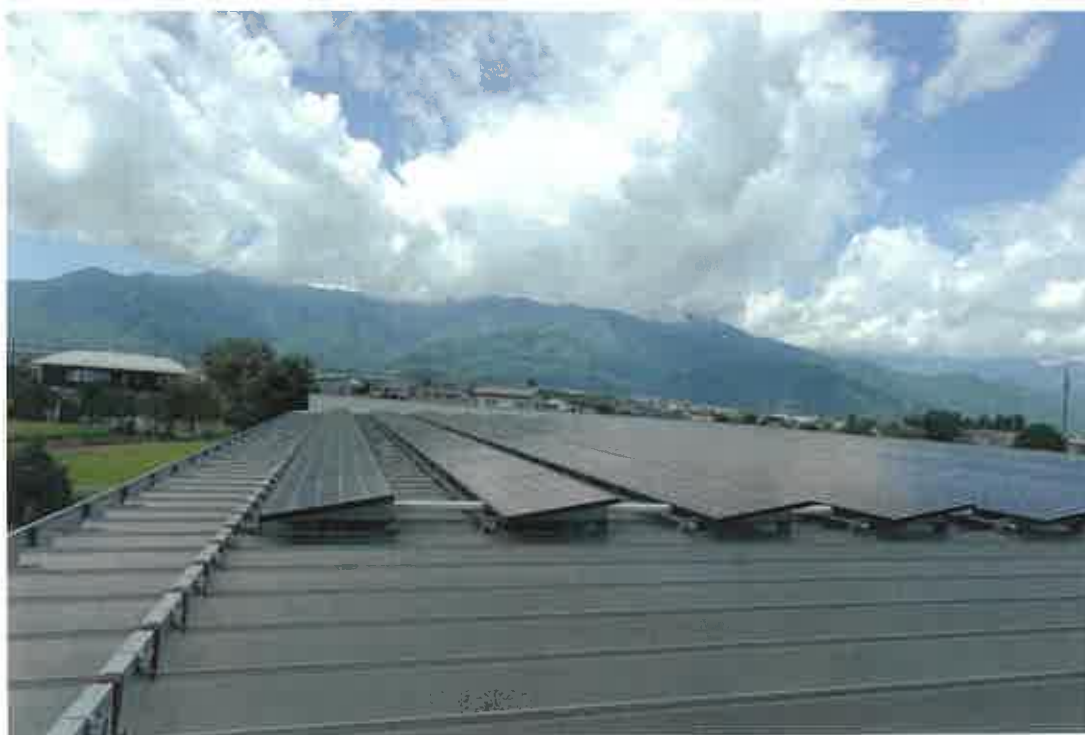
写真⑰（1階屋上）
