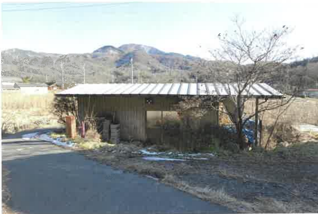
写真⑦（北西方向から撮影・未登記附属建物）
