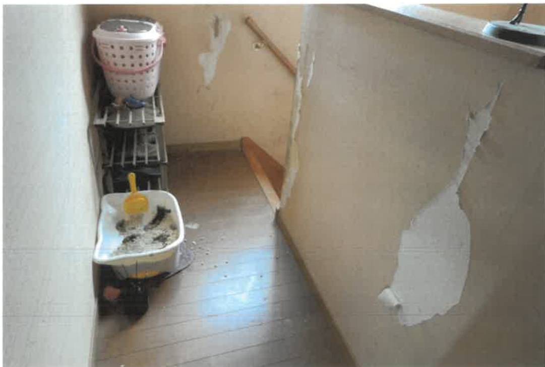
写真⑨（2階・廊下）
