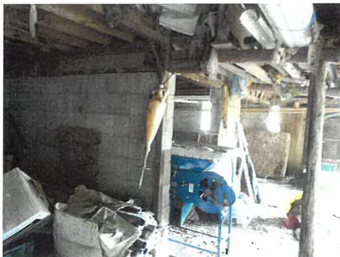
NO. 18（附属建物等の床下部分）
