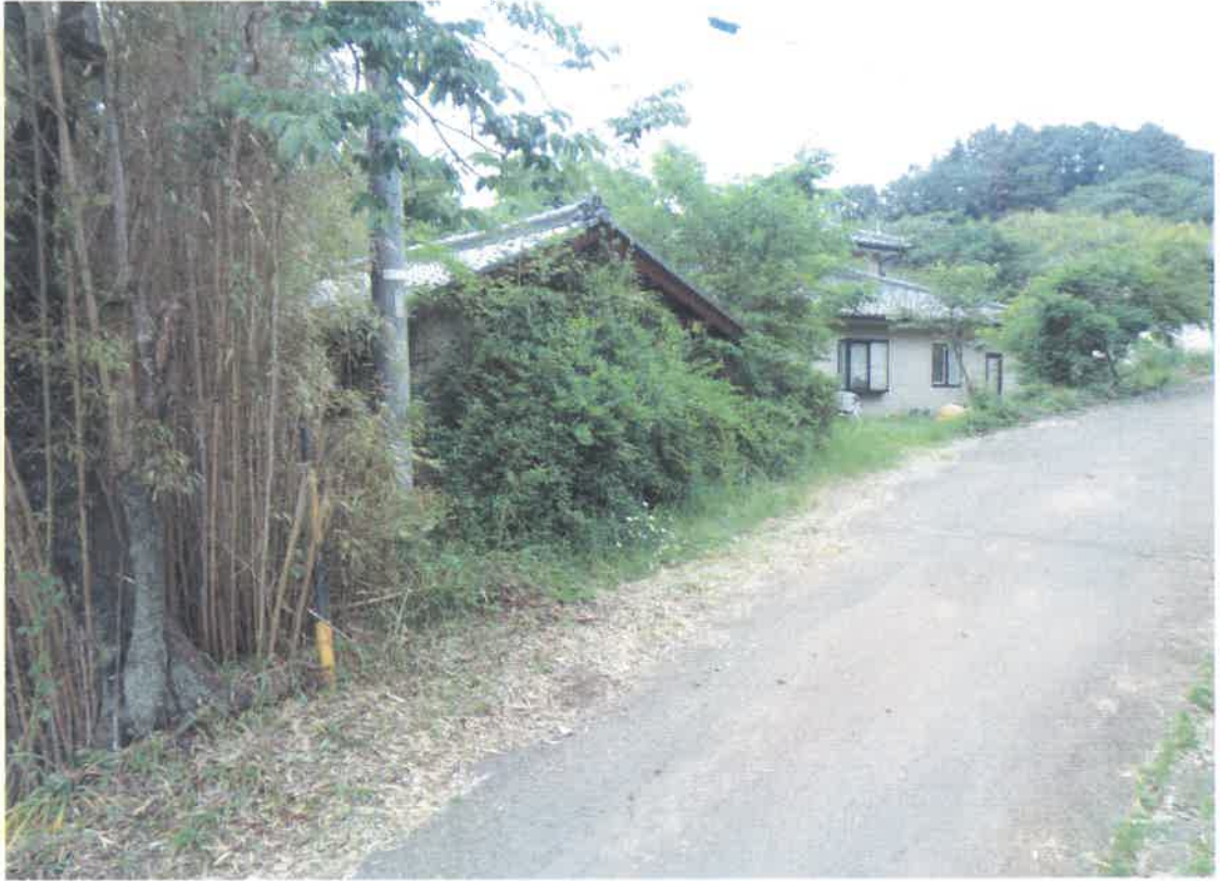
〈1〉、〈2主である建物〉、〈2未登記附属建物③〉
