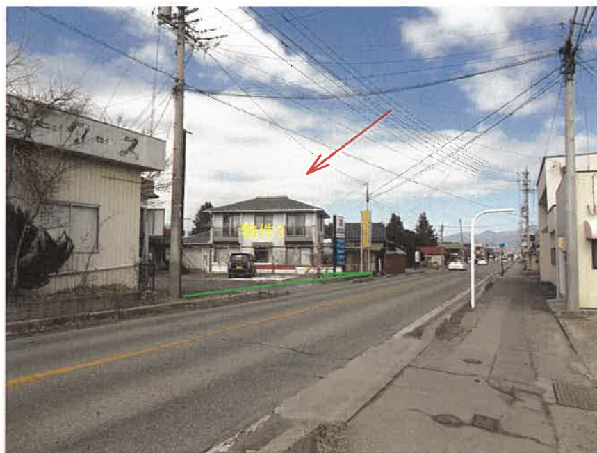
南東方より写
