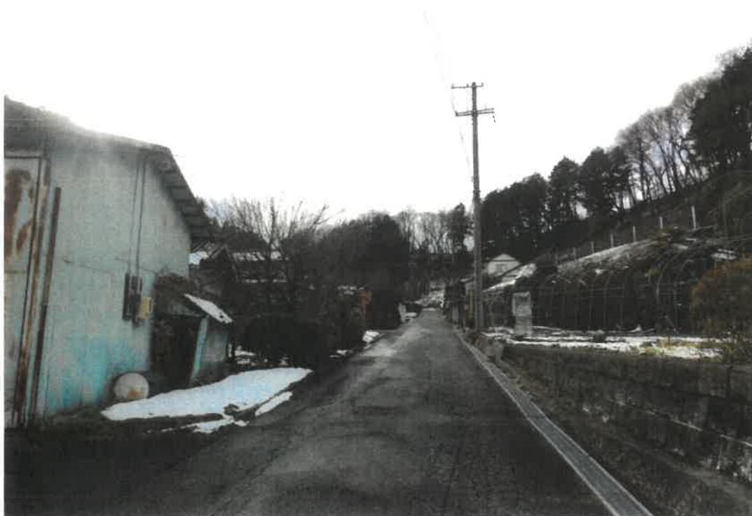
写真②（東方向から撮影）
