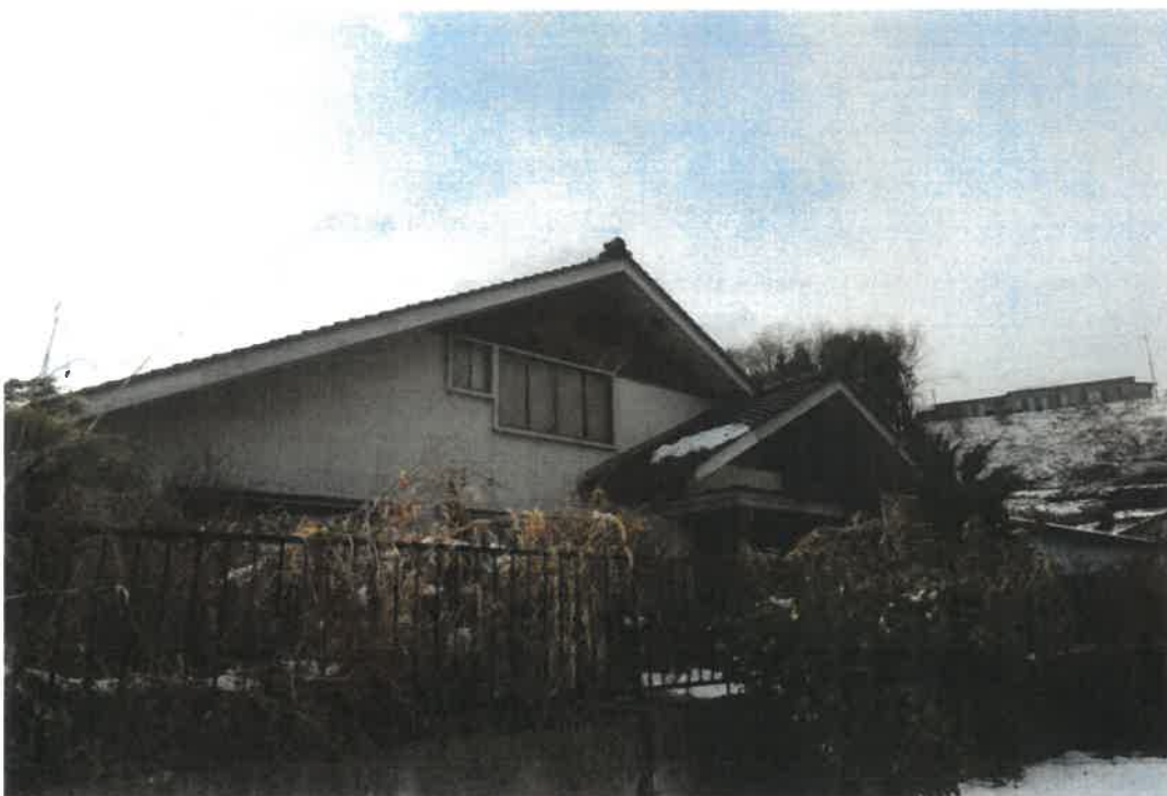
写真④（南東方向から撮影）
