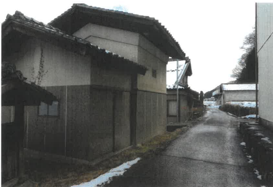
写真⑦（北方向から撮影）
