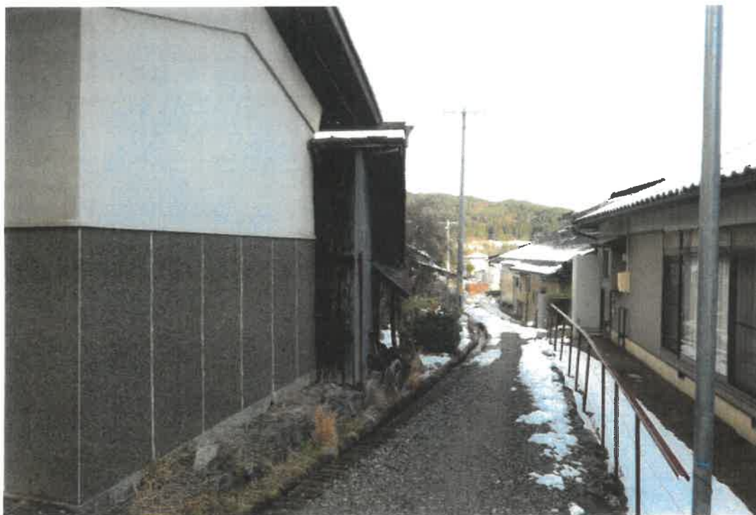
写真⑤（西方向から撮影）
