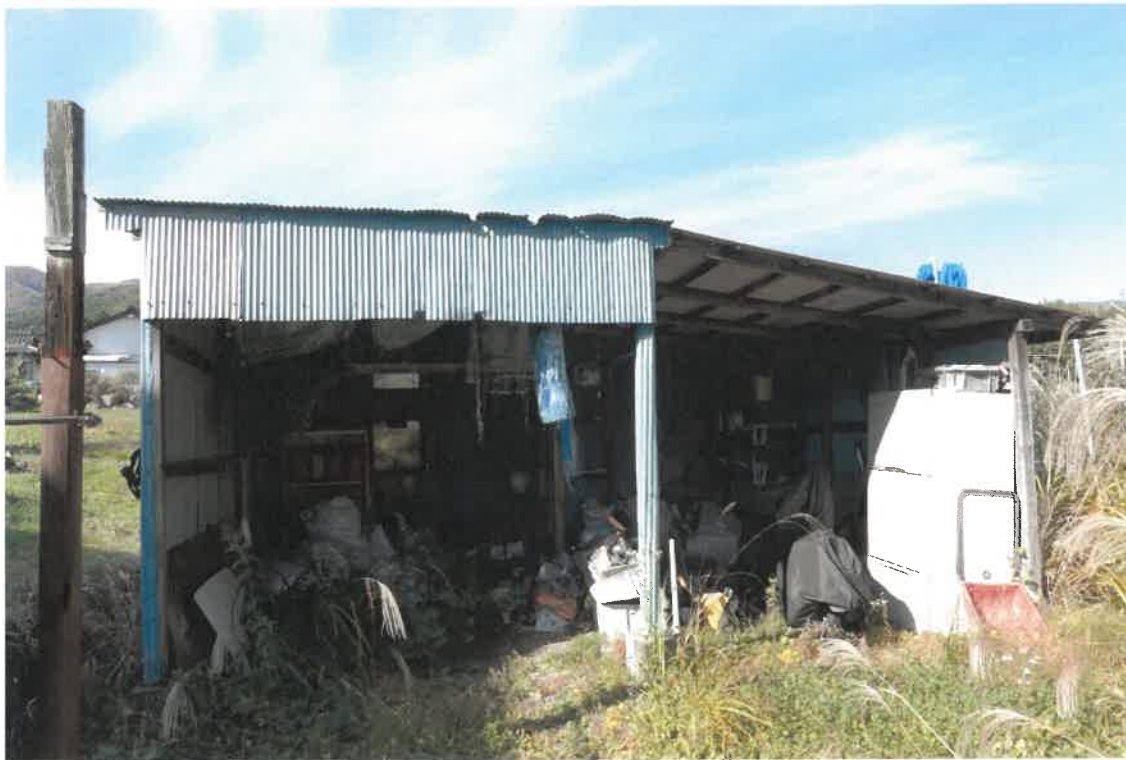
写真⑦（東方向から撮影）
