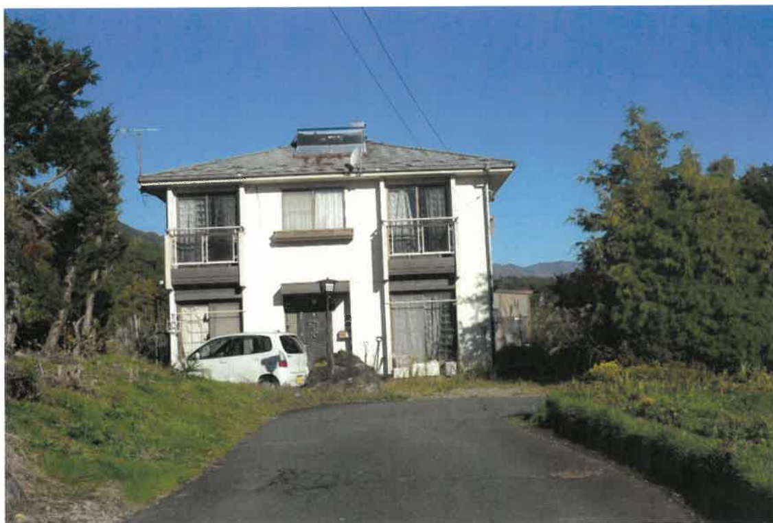
写真④（南東方向から撮影）
