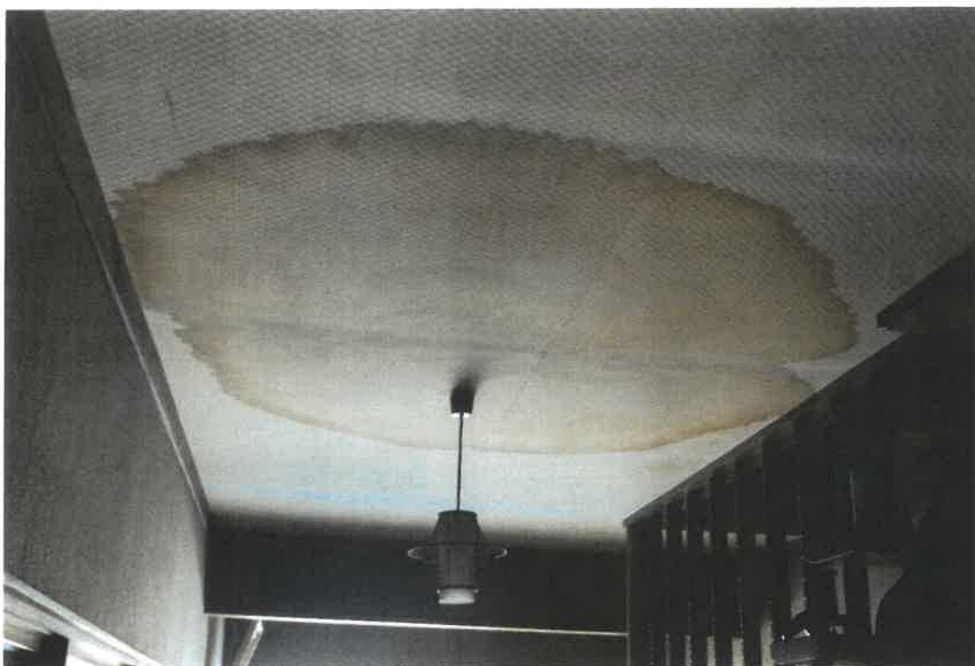
写真⑪（物件2の玄関付近1階天井）
