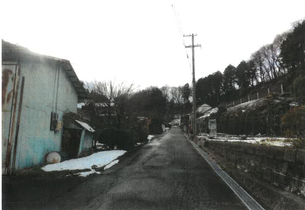
写真②（東方向から撮影）
