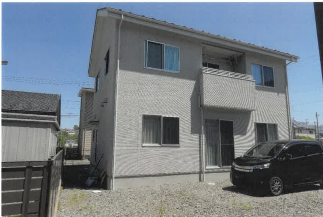
写真③（南西方向から撮影）
