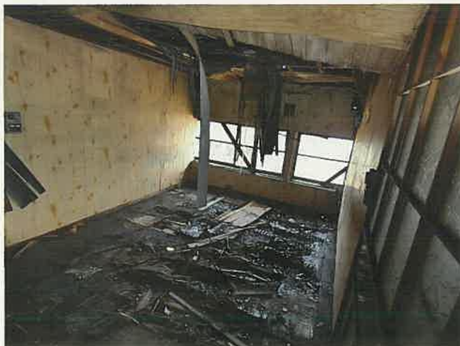
崩落した天井・腐食した床
