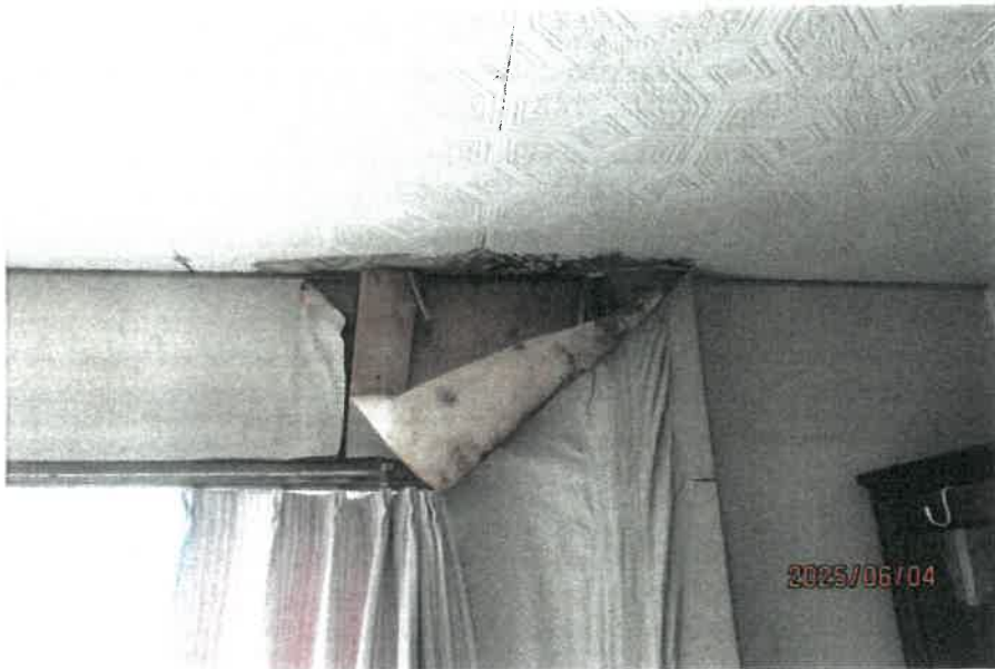
クロスが破損している状況
