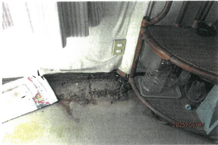
クロスが破損している状況
