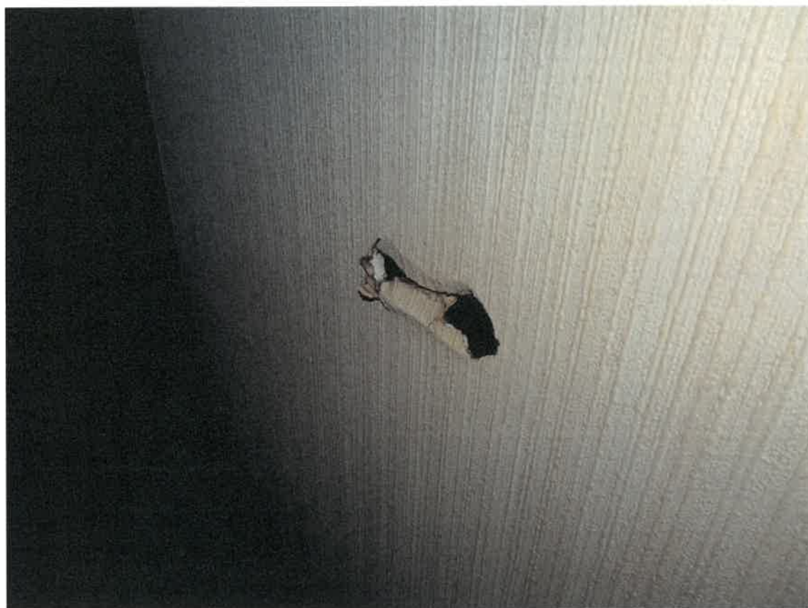
9 壁の陥没
