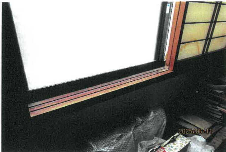
窓枠にカビが発生している状況
