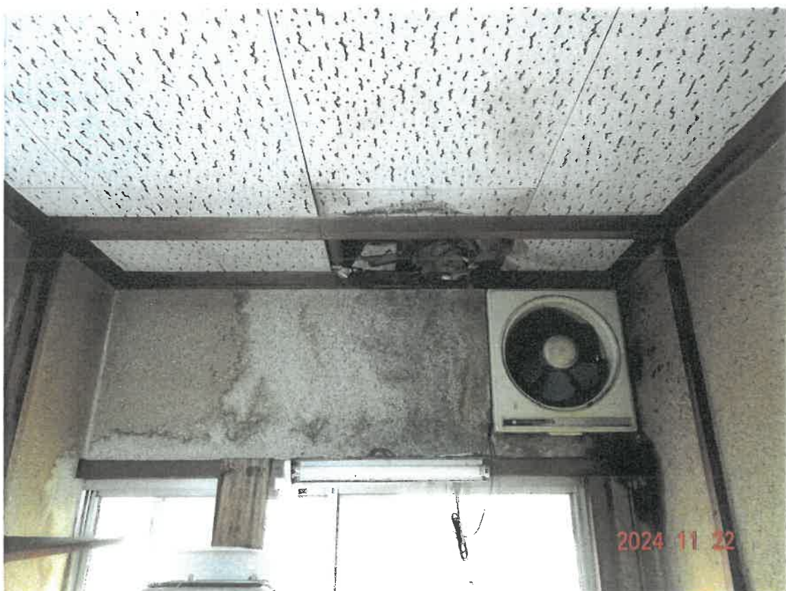
④雨漏りによるものと推測される破損部分
