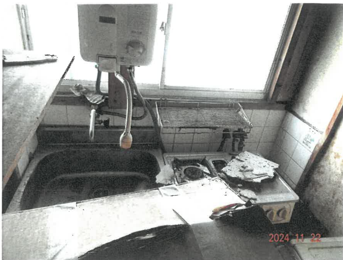
④雨漏りによるものと推測される破損部分
