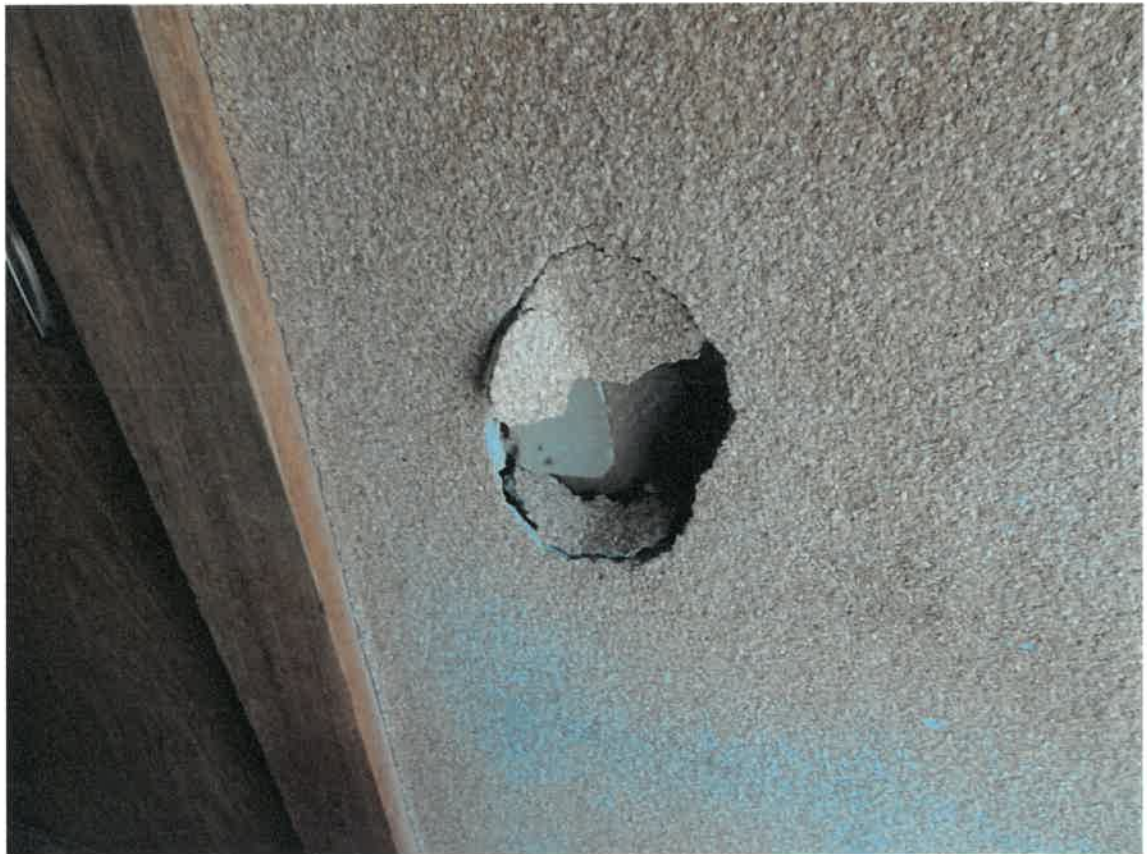
8 壁の陥没
