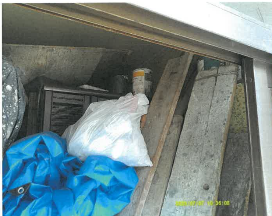
正面玄関内部の状況
