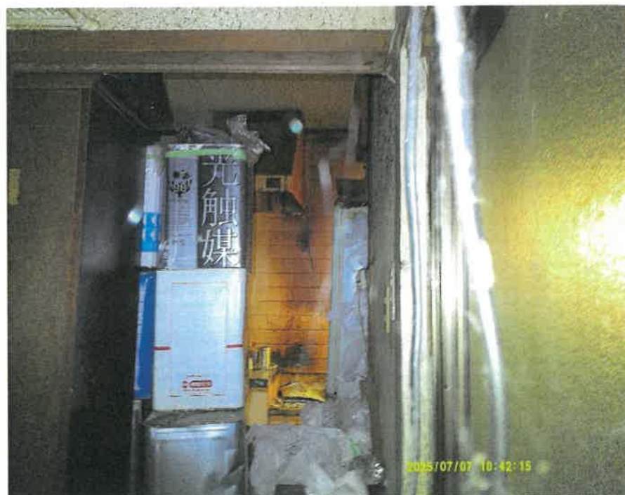
東側小窓から撮影した内部の状況
