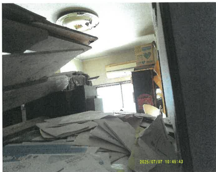
西側窓から撮影した内部の状況
