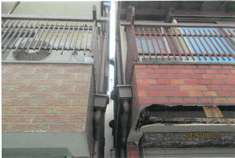
換気フードが隣家の雨樋と被っている状況
