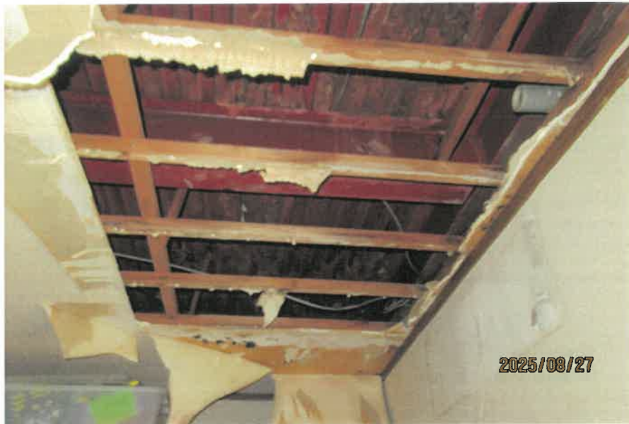
天井は崩落している状況
