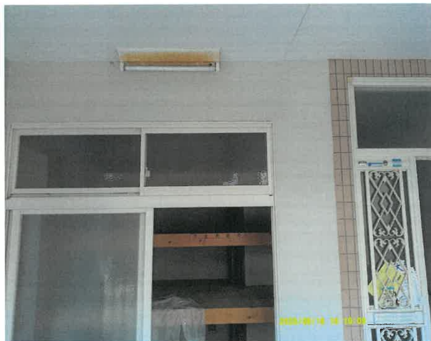
⑫ 1階北側増築部分（物置）
