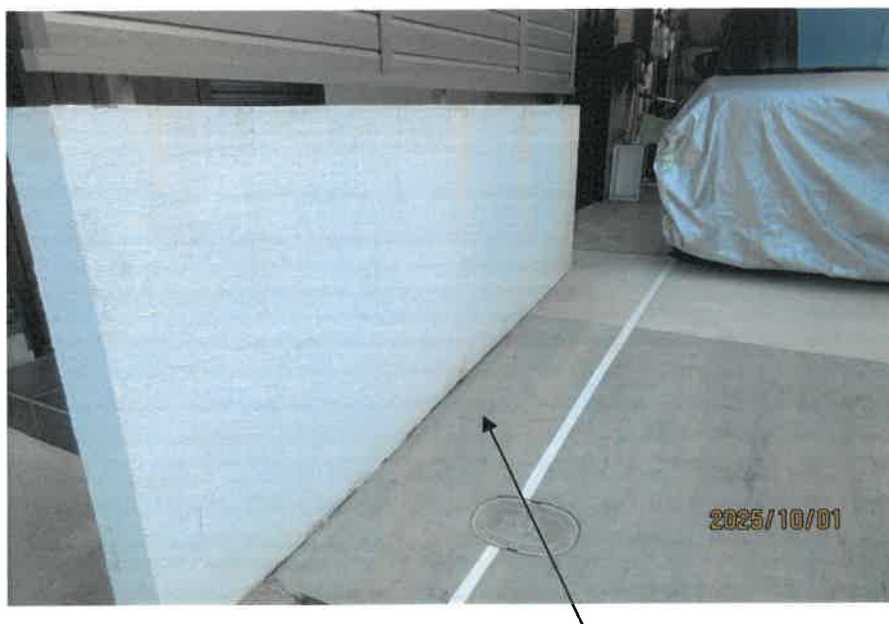
隣地に取り込まれている部分
