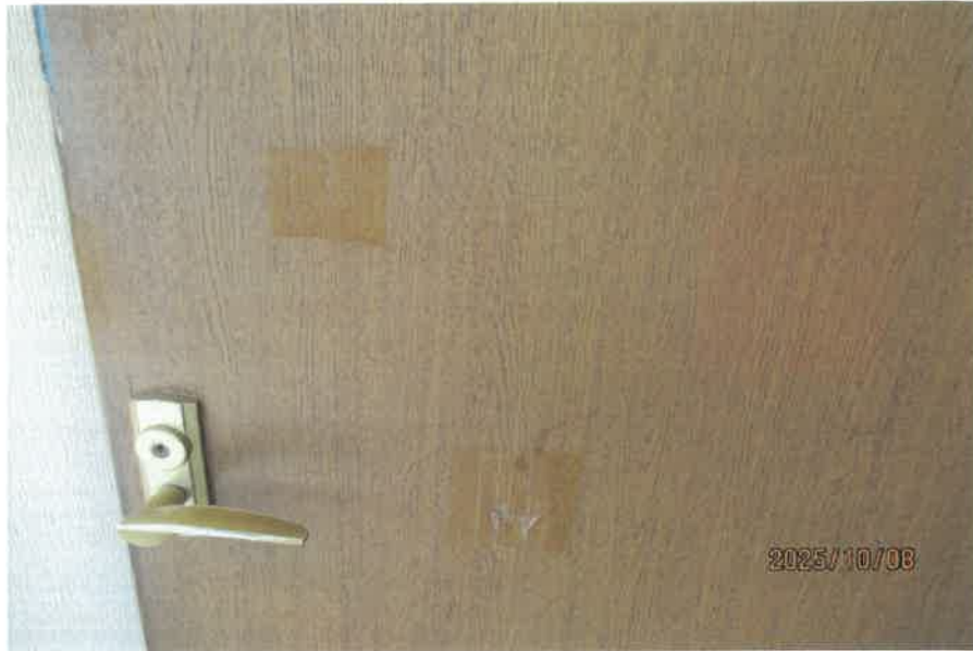
ドアが補修されている状況
