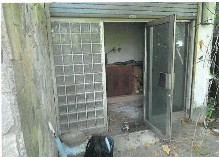
⑧ 物件2の玄関部分
