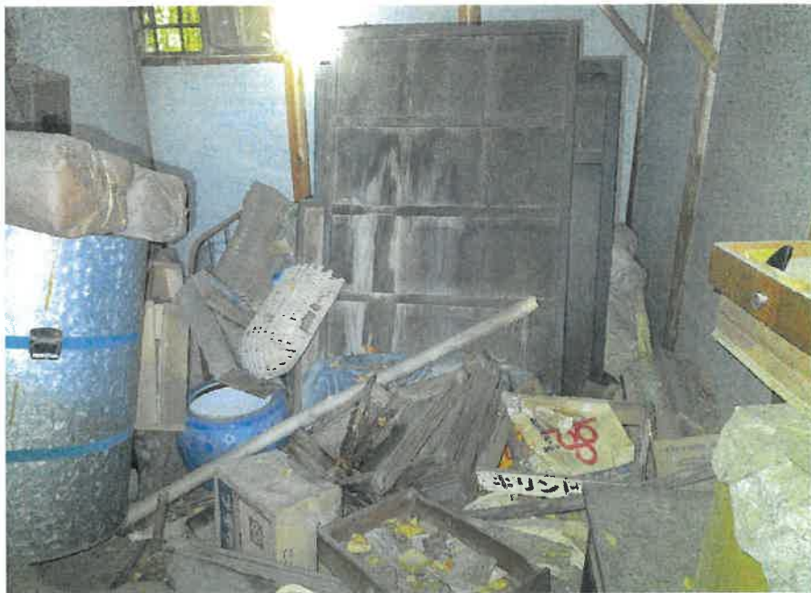
⑨ 物件4の1階東側部分
