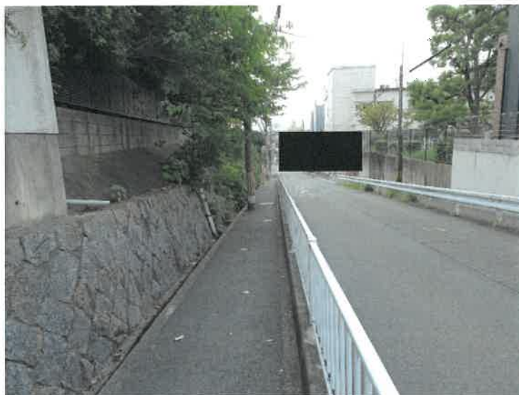
2 擁壁と西側接面道路
