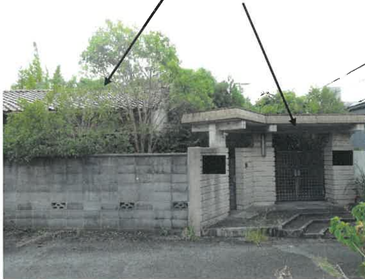
1 物件 4 建物と門扉
