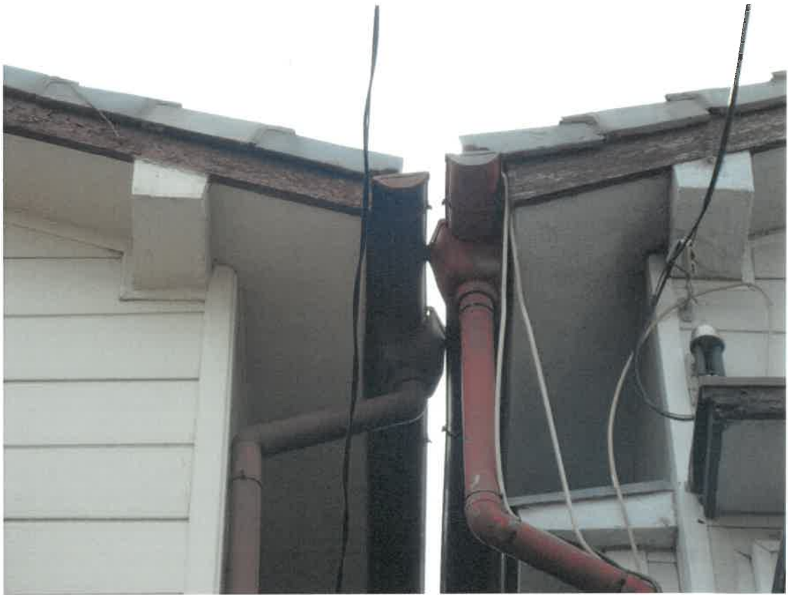
9 目的建物西側の雨樋部分（越境可能性あり）
