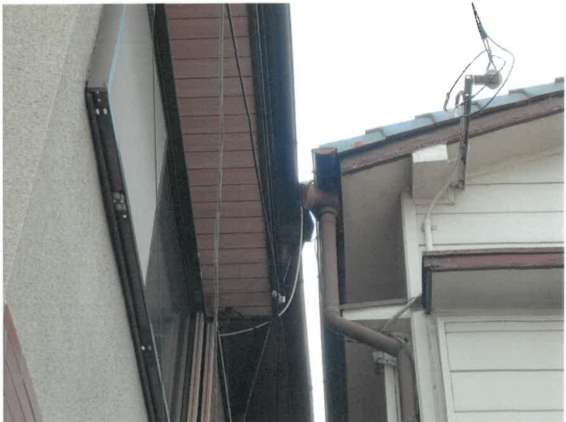
10 目的建物東側の雨樋部分（越境可能性あり）
