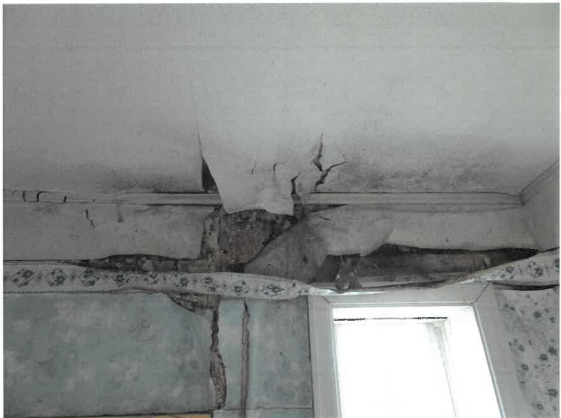
6 天井と壁面の損傷
