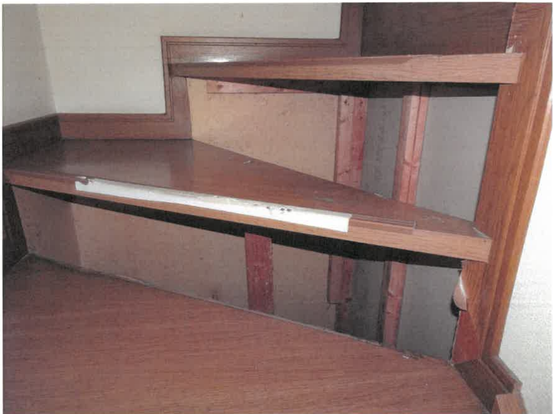
8 階段の破損
