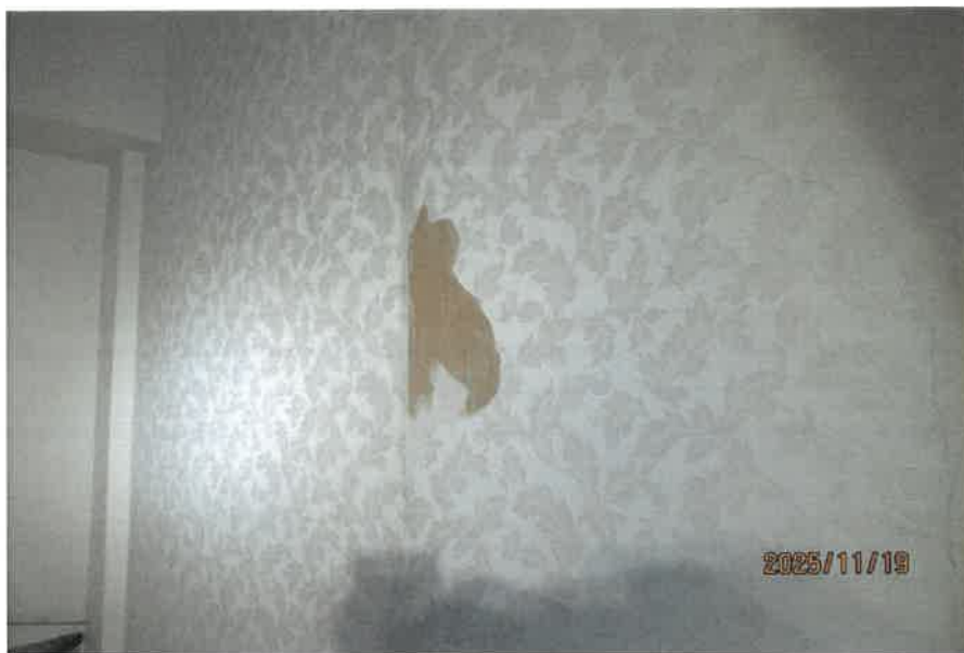
階段の壁紙が剥離している状況
